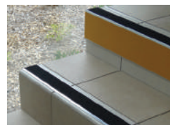
SÉCURISATION DES ESCALIERS
