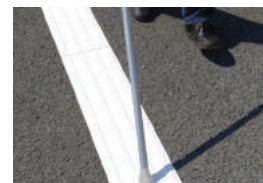
GUIDAGE AU SOL
