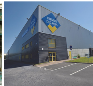
Plateforme logistique Lesquin (59)
